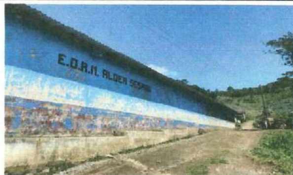
Foto 2: Mantenimiento de muros con aplicación de pintura en las paredes exteriores e interiores.
