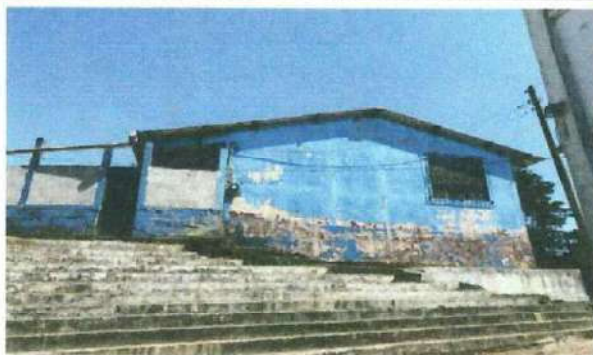
Foto1: Mantenimiento de muros con aplicación de pintura en las paredes exteriores e interiores.
