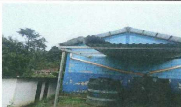
Foto 4: Sustitución de depósitos de agua por deterioro de los actuales y que son utilizados para la captación de aguas pluviales.
